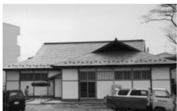
ぬくもりのある銅板葺きの屋根に覆われた白石市介護予防センター(旧刈田病院跡地内西側)
