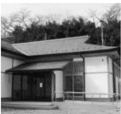
旧刈田病院跡地内西側に完成した介護予防センター
