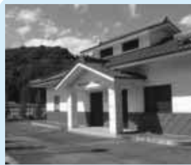
▲地区内の生活排水を集めて処理している「薬師堂クリーンセンター」
