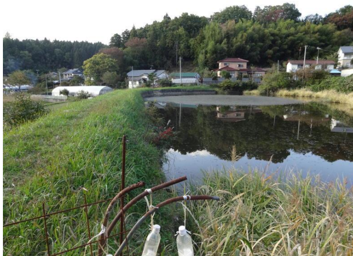
鷹巣奥ため池（道路奥 2つ目）
