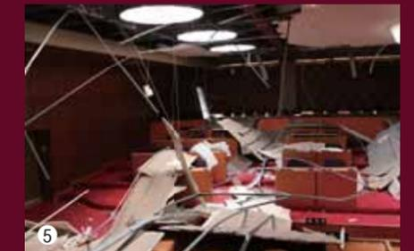
①道路に大きな被害を受けた白川内親地区 ②ブロック塀が倒れた市道南小路線 ③大きな被害を受けた館堀 ④地震で橋と道路に段差が生じ、車両通行止めとなったしらさぎ橋 ⑤天井が落下した市役所5階議場
