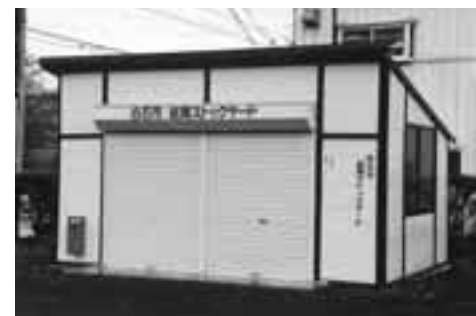
（中央公民館敷地内のストックヤード）
