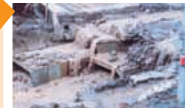
▲1991年雲仙普賢岳で発生した土石流
