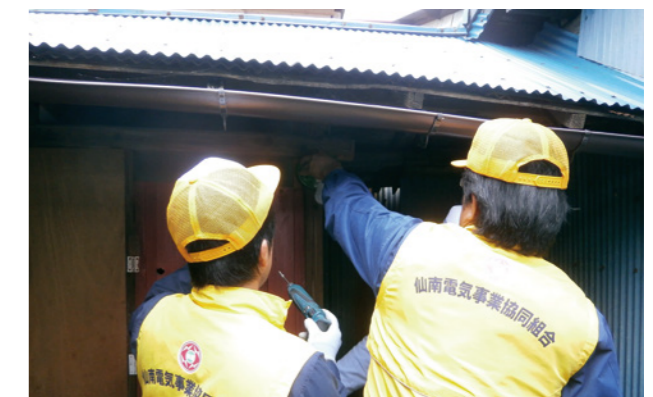
▲点検作業を行う仙南電気事業協同組合員
