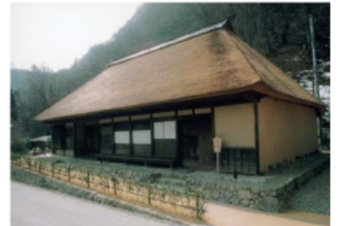
宮城県指定有形文化財 復原後の検断屋敷
