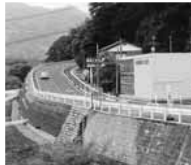
▲改良された県道南蔵王白石線(白石大橋～4号バイパス)
