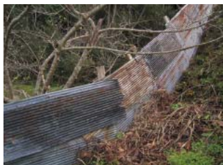
傾斜が大きく変わる箇所はトタン板を十分に重ねて隙間をなくす
