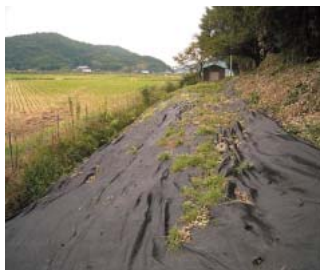
林縁部の斜面をシートで覆う
