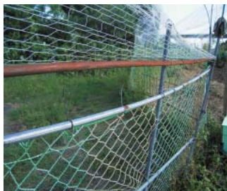
柵の出入り口にできた隙間
