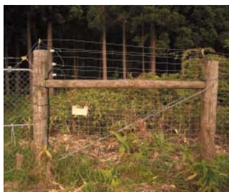
金網柵の上に電線を張る
