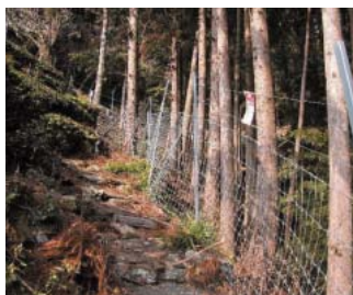
金網柵上部に電線が張られているが、この状態では立木からサルが柵内に跳び込める
