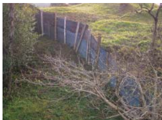
傾斜地で2段に重ねられたトタン板
