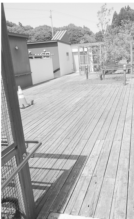
改修されるシルバーハウジングデッキ
