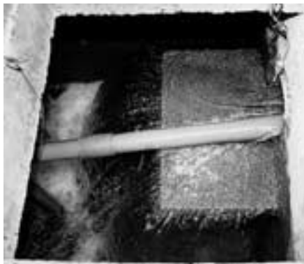
濁りのほとんどない三住水源の着水井(右)と濁度計
