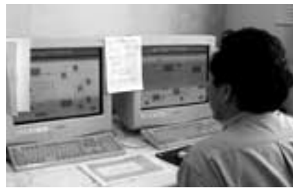
配水池の水位、濁度などが一目でわかる水道事業所のコンピュータ
