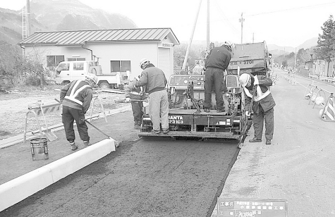
小原地区歩道設置工事の様子
