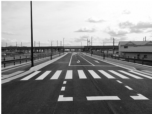
沖の沢郡山線は開通しています。
