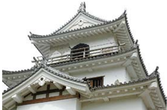
壁に亀裂が入った白石城
