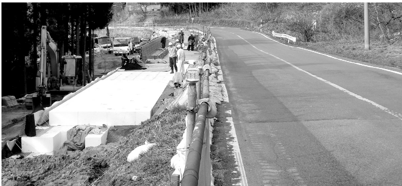
国道113号小原地区歩道設置工事の様子
