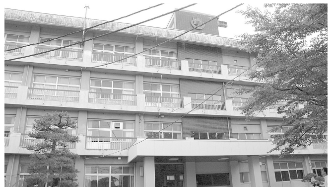
取り壊し予定の旧白石高等学校
