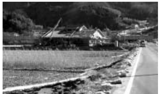
工事の進む越河地区農業集落排水事業（排水処理場）
