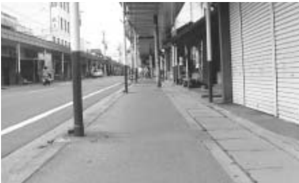
カラー舗装される歩道
