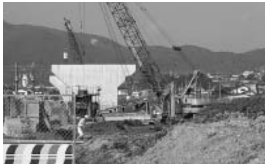
工事の進む 沖の沢郡山線
