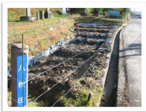
▲遮水シートを使い改修工事をした田の様子
