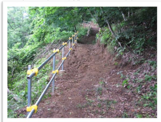
▲足場の悪い約1キロの遊歩道を均し、特に危険な3箇所に手すりを設置
