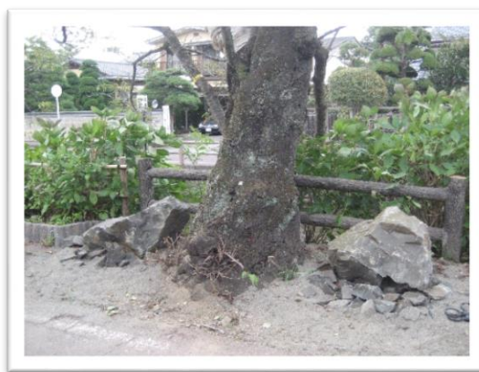
▲市道調練場北線歩道脇に影石を設置
