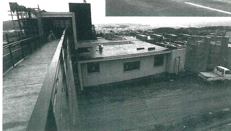
▲着々と工事が進む「福祉の里」
