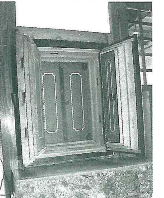
▼壁にうめこまれた金庫。
