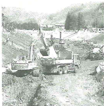
斎川の河川改修工事(郡山橋付近)
