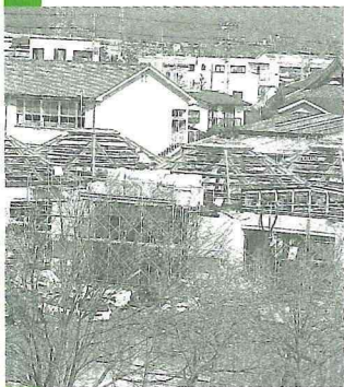
第二小学校の改築工事
