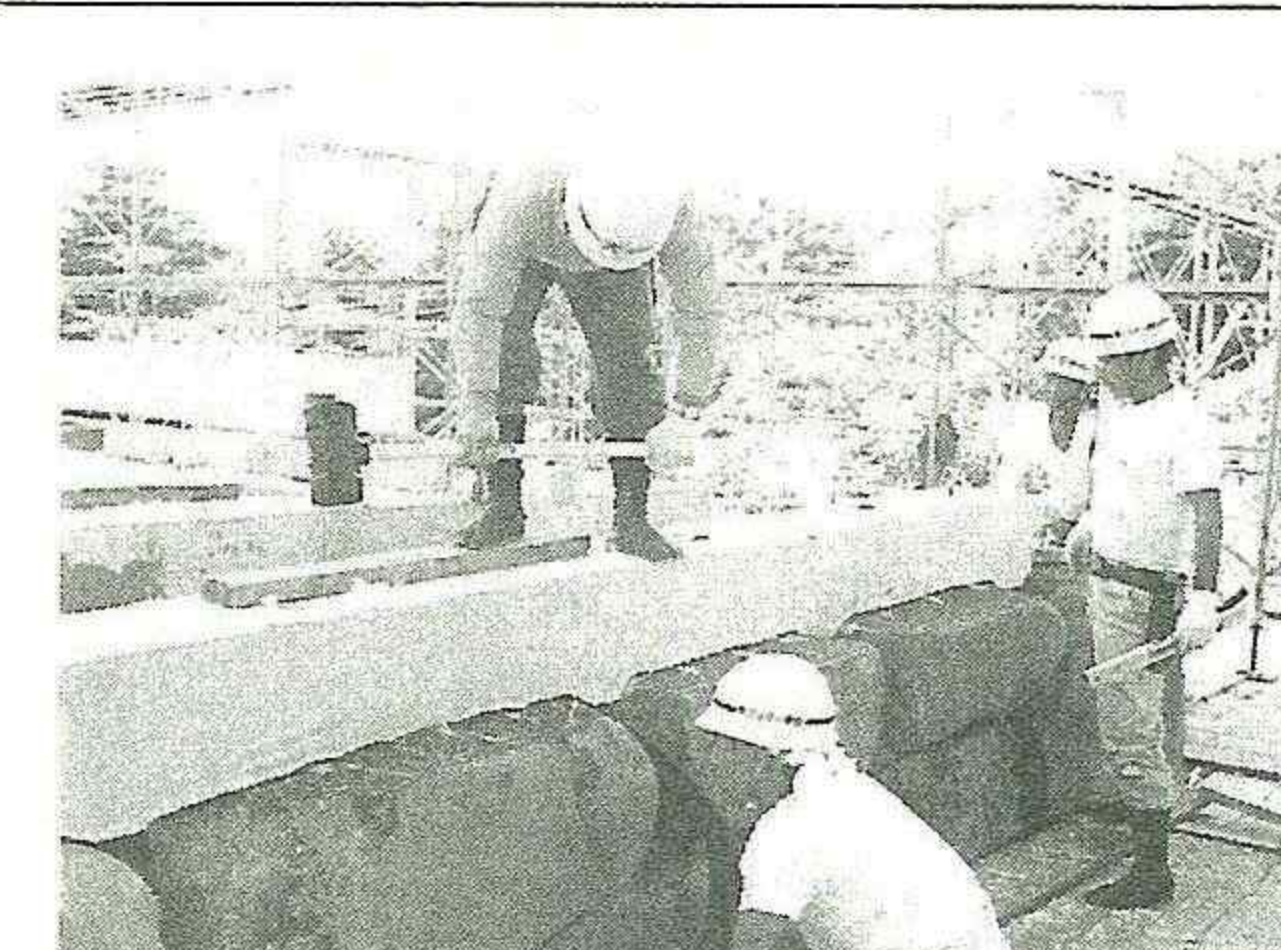
10月 三階櫓の土台据えつけ
