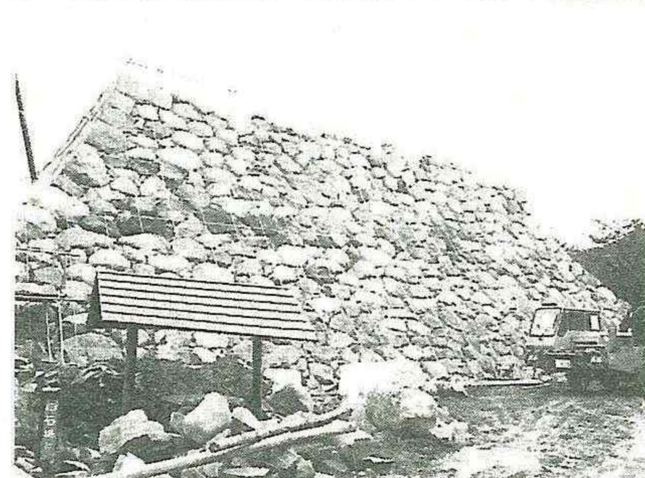
9月 三階櫓部分の石垣が完成
