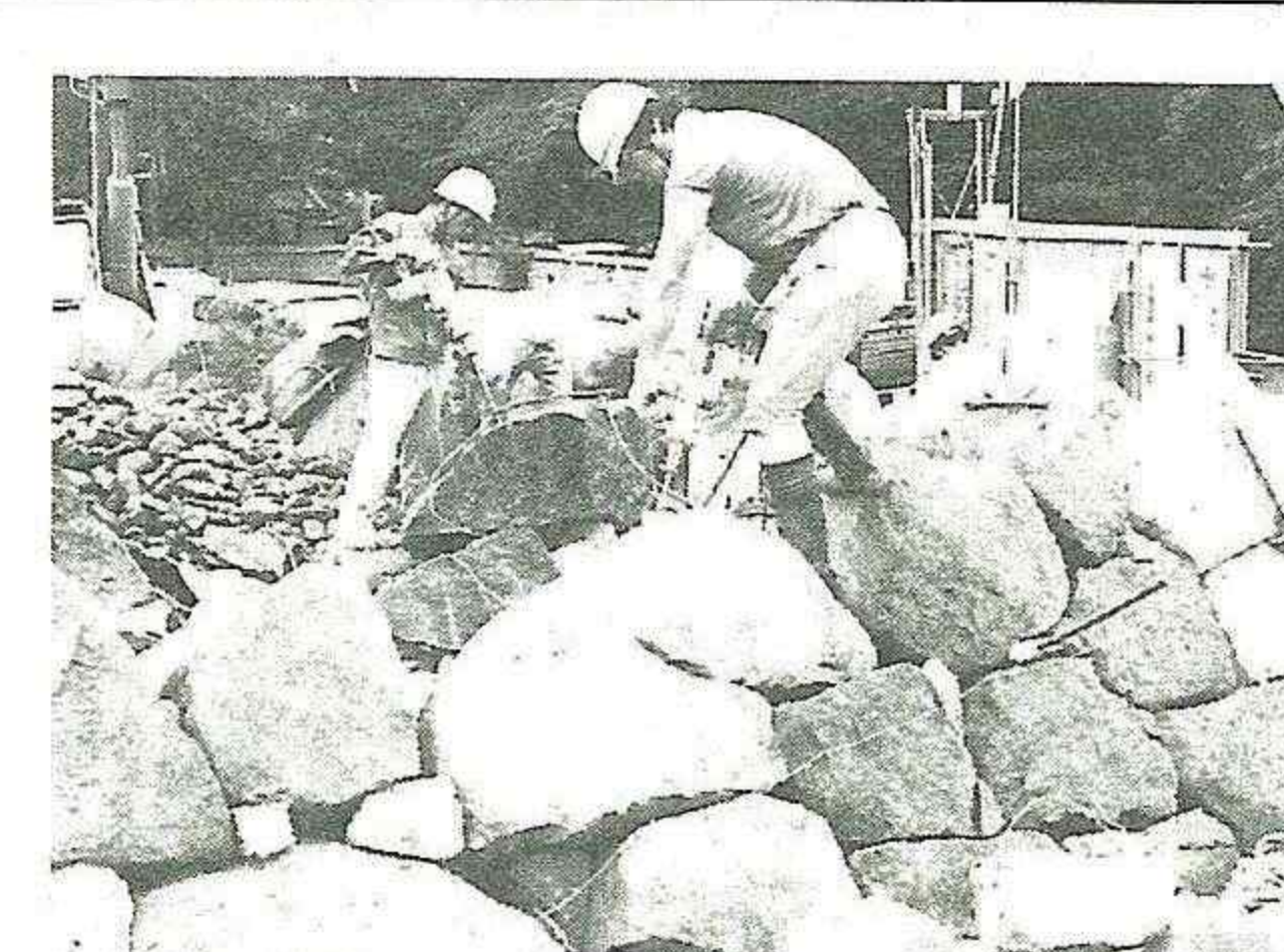
9月 引き続き大手門部分の石垣積み
