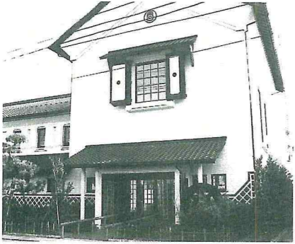
城北町にある水道事業所庁舎
