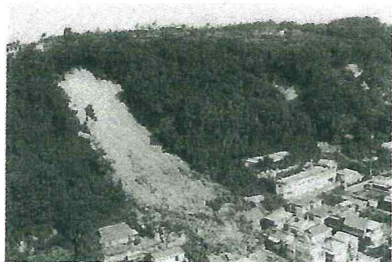
鹿児島市で起きたがけ崩れ(昭和61年7月)
