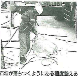
石垣が落ちつくようにある程度整える
