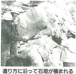
遣り方に沿って石垣が積まれる
