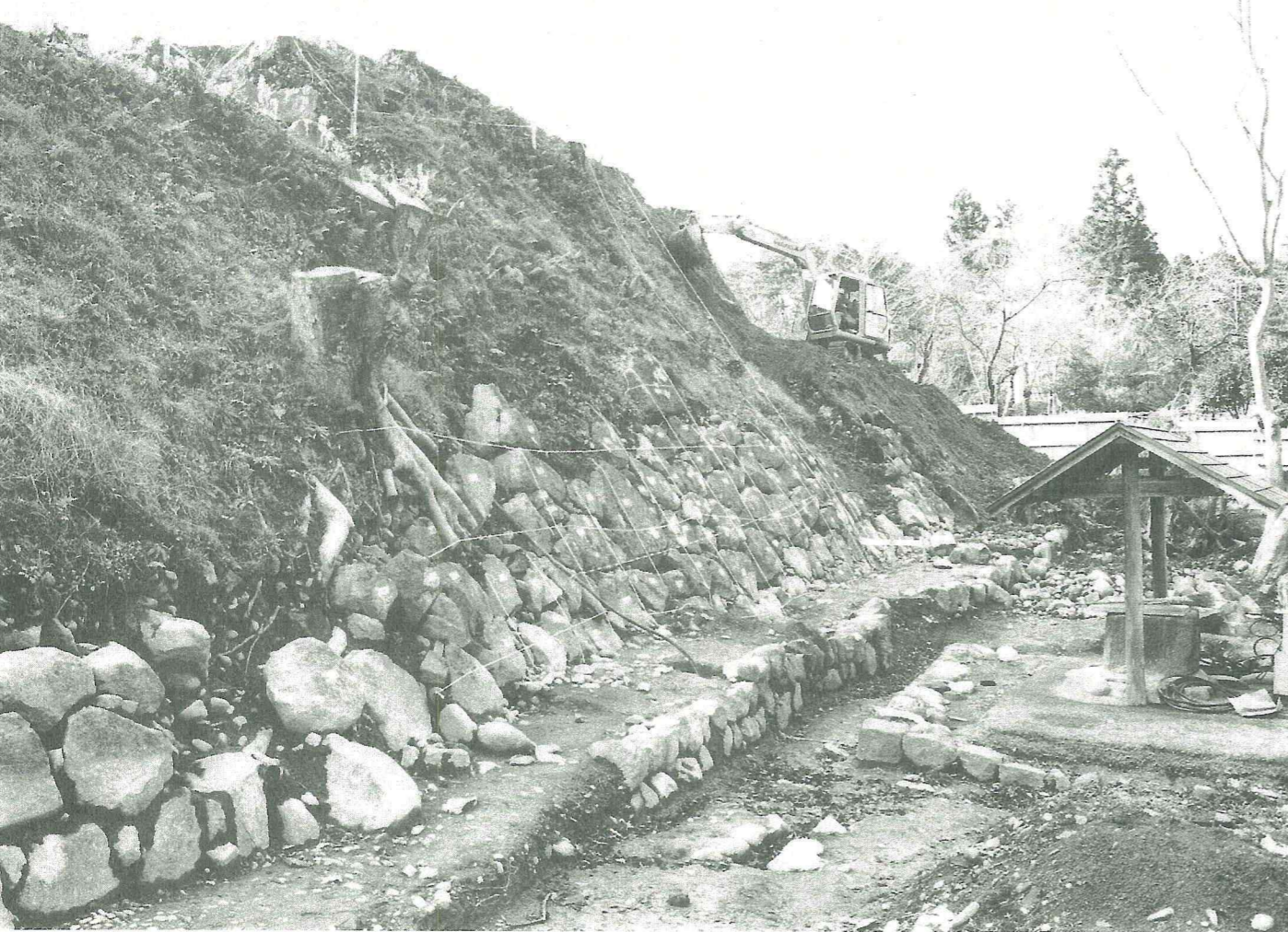
▲白石城の復元は、残っている石垣を取りはずす作業を昨年から行っています。
