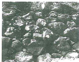
▲石と石との間にすき間がある野面積みという古い石積み方法
