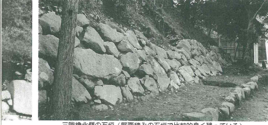
三階櫓北側の石垣（野面積みの石垣で比較的良く残っている）
