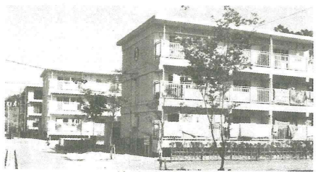
▲城南市営住宅
