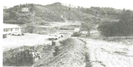
▲仮称東中学校造成地
