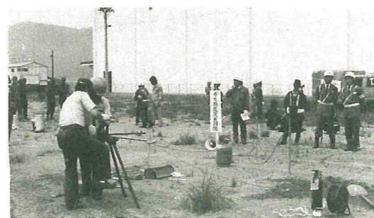
▲ガス施設復旧訓練
