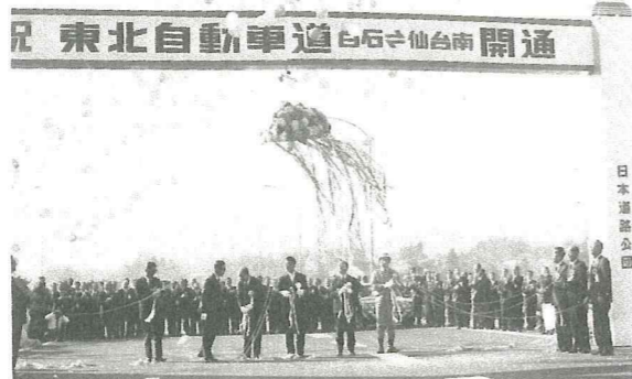
▲48年 東北縦貫道白石～南仙台間開通
