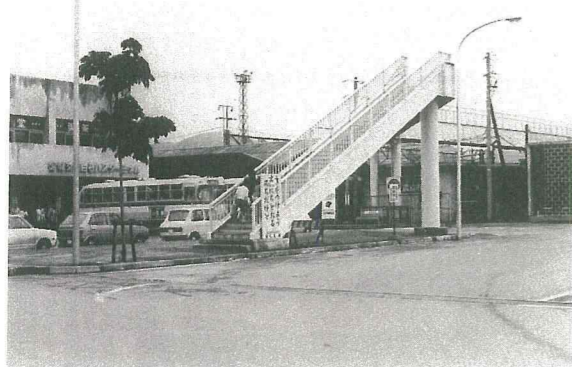
▲49年 白石駅跨線橋完成
