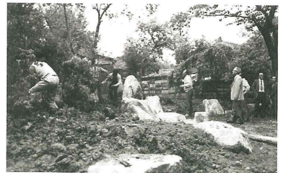
庭園造成奉仕作業
