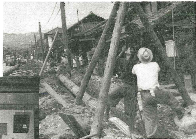
上水道配水管工事
