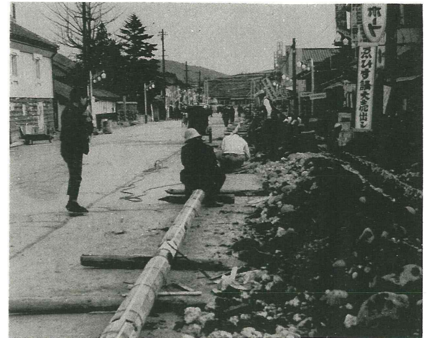
駅前の上水道配水管工事
