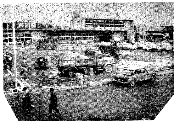
写真——完成間近い白石駅前広場
