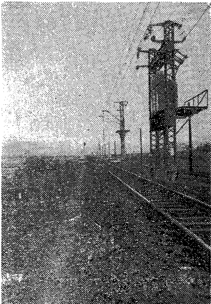
【写真は工事着工を待つ越河～白石間】
