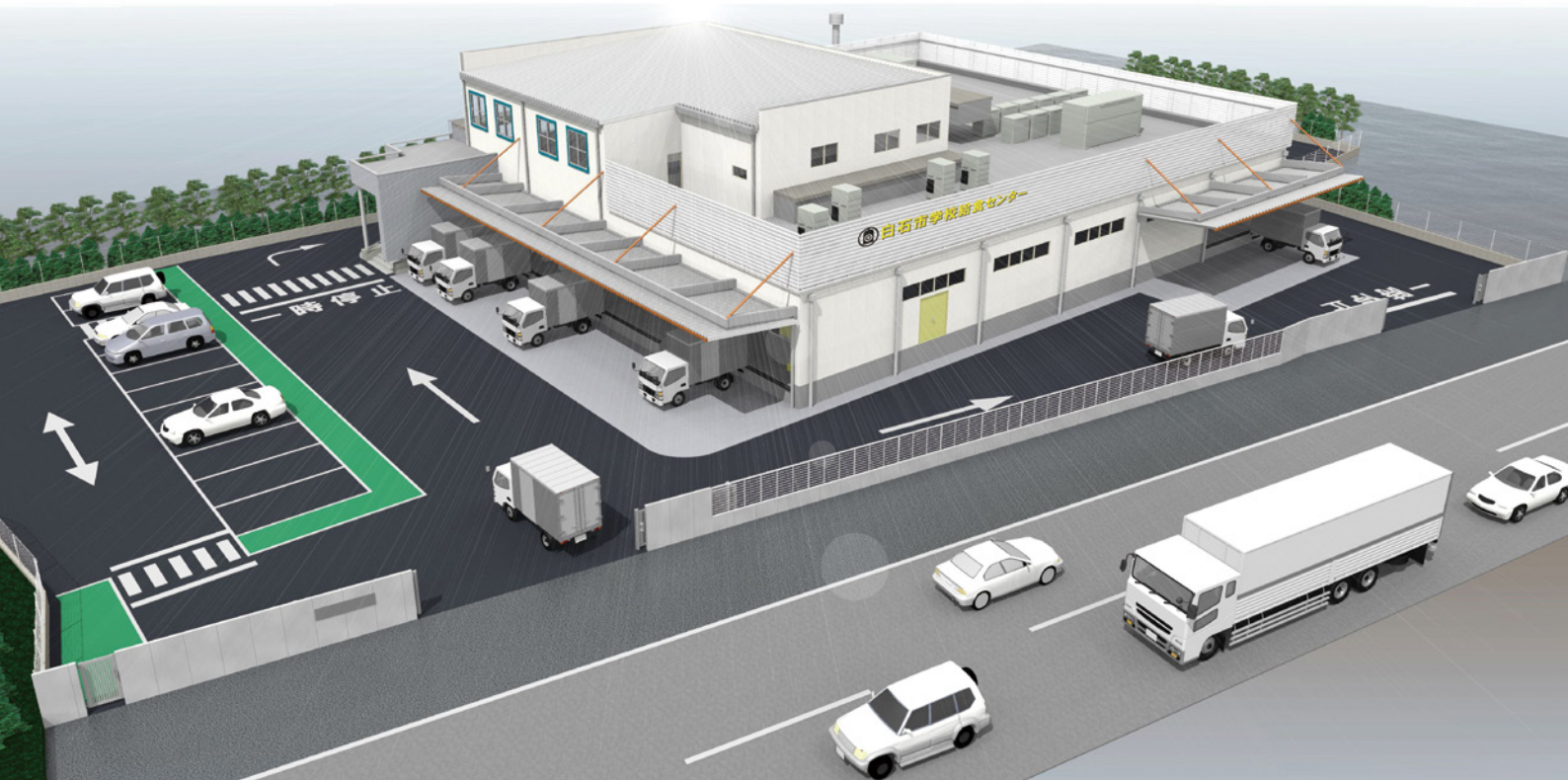
▲8月に大平地区に新設する白石市学校給食センター
