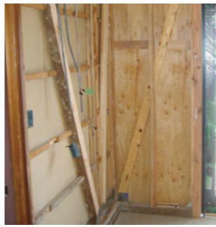
▲壁に筋かいを入れて耐震補強
