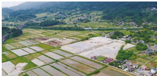
▲着々と進む造成工事 (令和6年6月撮影)
