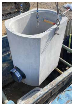
▲下水道管路移設工事
