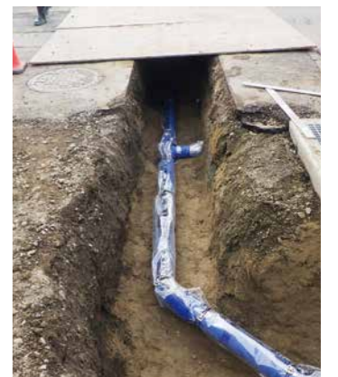
▲移設工事により布設した配水管(耐震管)
