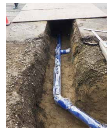
▲移設工事により布設した配水管(耐震管)
