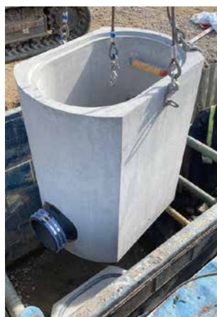
▲下水道管路移設工事
