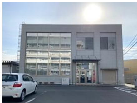
防災センター
