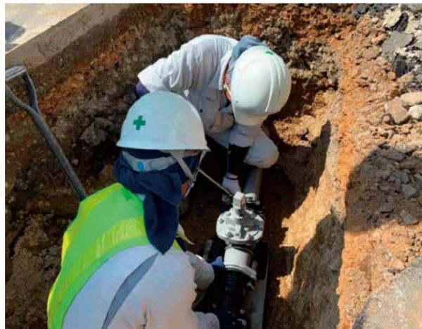
▲耐震性能を有する資材の取り付け作業状況
