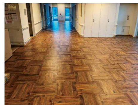
▲3階病棟の床（工事後）
