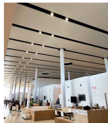
▲明るくなった1階受付ホール
