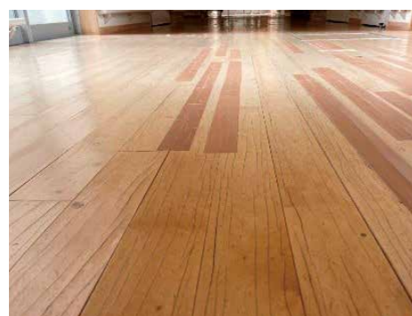
▲3階病棟の床（工事前）
