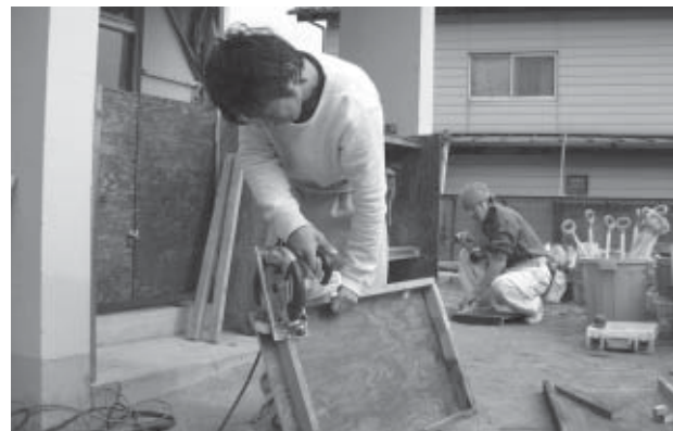
▲手際よく収納棚を修理
